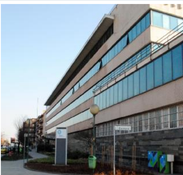
Una veduta della sede di Brescia del gruppo A2A in via Lamarmora
