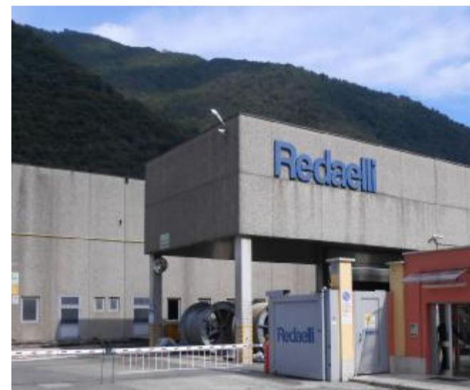
Una veduta esterna della Redaelli Tecna a Gardone Valtrompia
