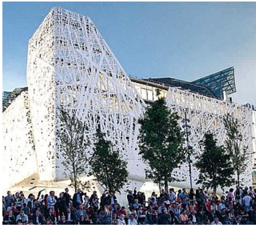
Palazzo Italia La struttura esterna e le facciate interne sono state realizzate con la malta Italcementi
