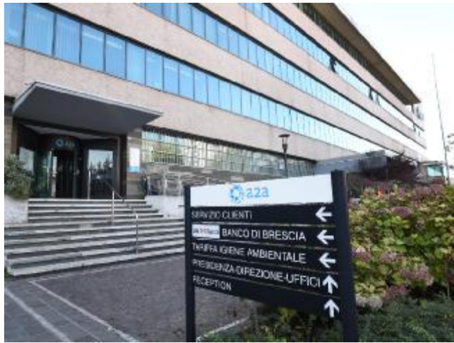
Una veduta esterna della sede di A2A in via Lamarmora a Brescia
