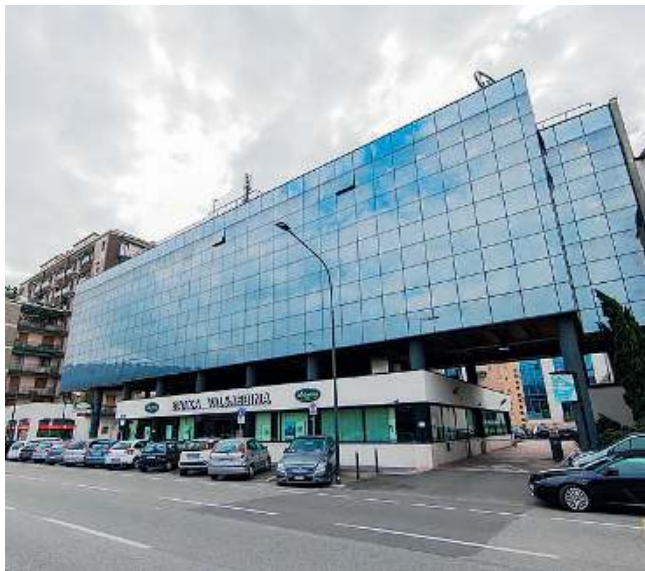
Il quartier generale. La sede a Brescia di Banca Valsabbina
