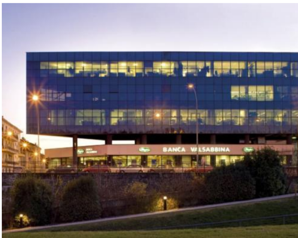
Una veduta esterna del quartier generale a Brescia di Banca Valsabbina, nata nel 1898
